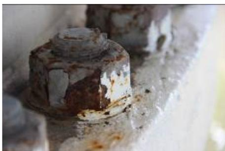
a 螺栓上部腐蚀形貌
