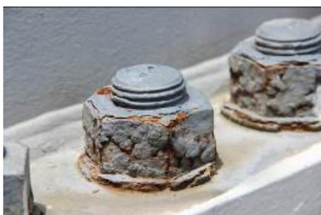
c 螺栓宏观腐蚀形貌 1
