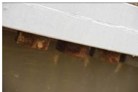
b 螺栓下部腐蚀形貌
